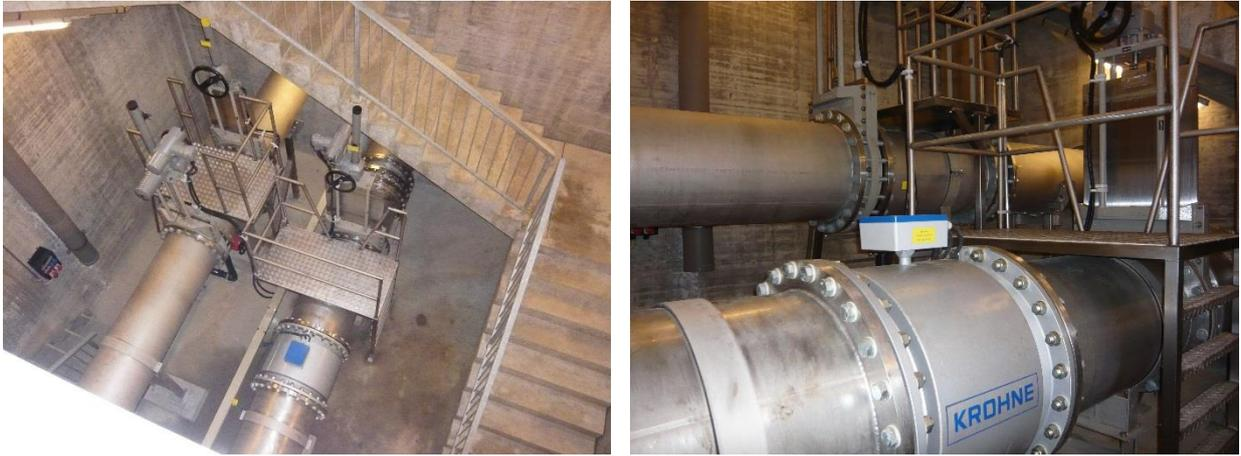
Figure 13. Conduite fermée en sortie de la galerie de Chouilly (à gauche) et débitmètre électromagnétique Krohne associé (à droite).
