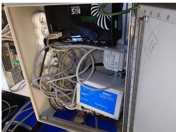
Figure 63. Vue du boîtier d'alimentation et de communication Ponsel Module 4001 et de la centrale d'acquisition Sofrel S550.
