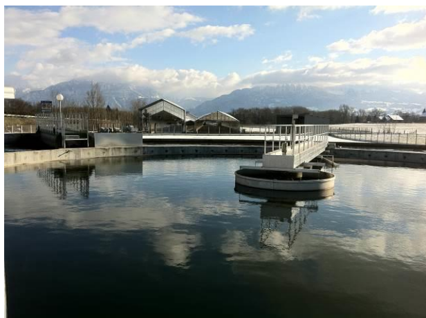
La station d'épuration de Bellecombe
