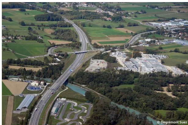
Vue aérienne du site pilote de Bellecombe pendant la construction du Centre Hospitalier Alpes Léman
