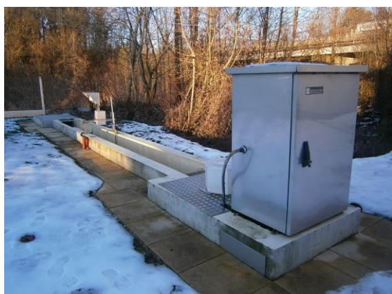
Préleveur fixe de la station d'épuration de Bellecombe
