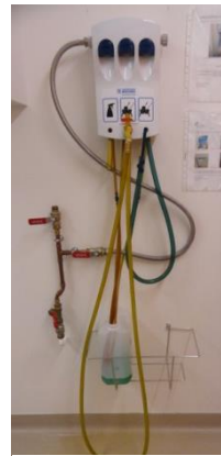
Figure 5 : Centrale de dilution installée au CHAL
