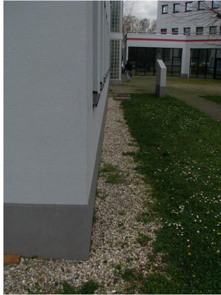
Cette tranchée d'infiltration est située au ras des murs de l'immeuble. Elle recueille uniquement les eaux de la toiture.
