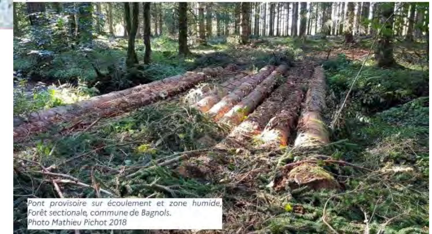
Pont provisoire sur écoulement et zone humide,
