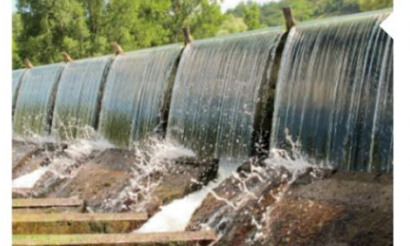
France Hydro Électricité
