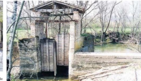
En 1997 à Cap d'Aze, la structure était réparable à moindre coût et avec une échelle à poissons.
