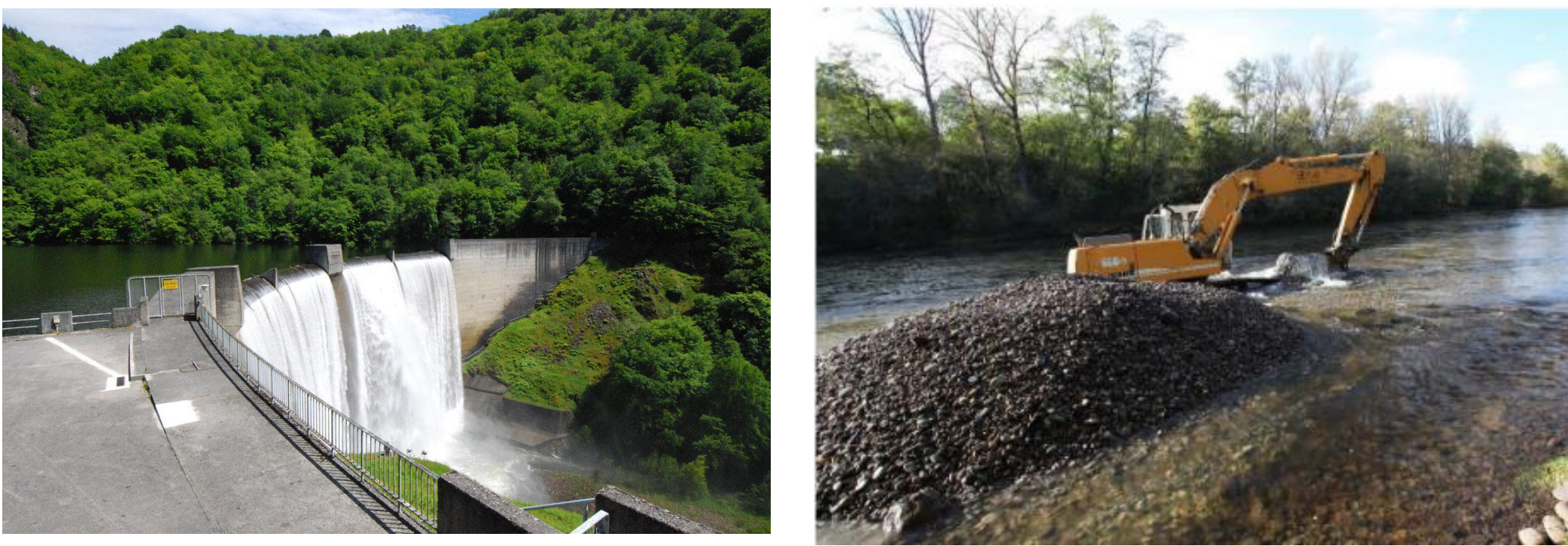
Fig. Site d'étude : Maronne (Corrèze) en aval du barrage d'Hautefage ▶
