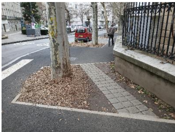
Détail désimperméabilisation d'un pied d'arbre
