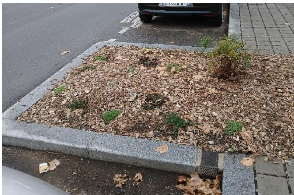
Vue point d'entrée des eaux pluviales dans le drain
