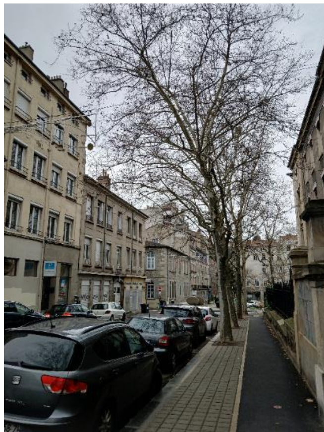
Pavés non jointés
