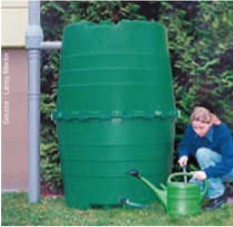
Exemple de système simple de récupération des eaux pluviales pour les besoins des espaces verts
