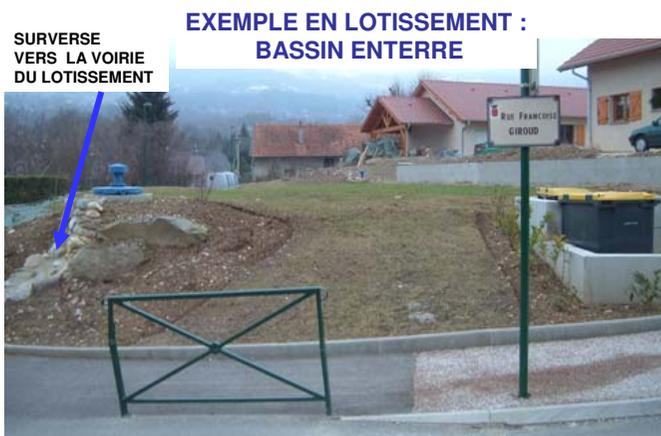
**CARACTERISTIQUES :** Surface lotissement: 4,8ha , volume de rétention: 475 m<sup>3</sup>, bassin maçonné avec évacuation vers le réseau d'eaux pluviales.
