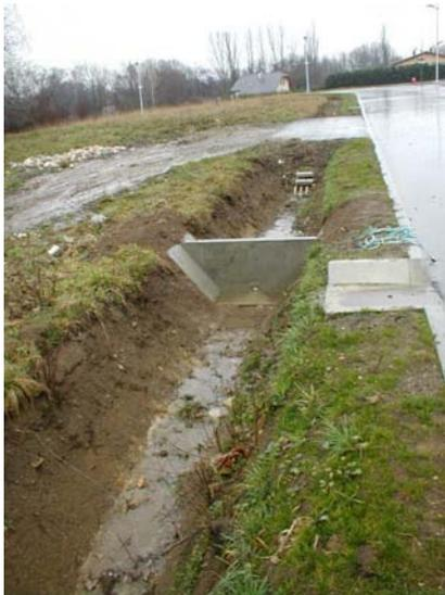
Noue : récupération des eaux pluviales de voirie (exemple du Terraillet)
