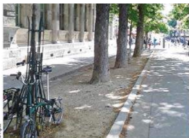
Tranchée continue avec bordure, Paris 4 e
