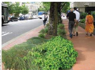
Tranchée continue recueillant les eaux pluviales, Portland
