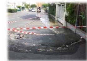
Débordement d'eaux usées à Talence
