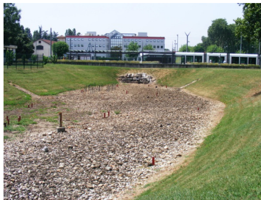
Figure 5 : instrumentation du site de l'IUT.
