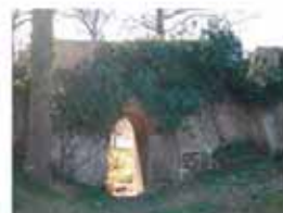
Ouvrage ancien du ruisseau du Bois Chenu
