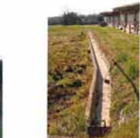
Rigole d'irrigation en état sur le site
