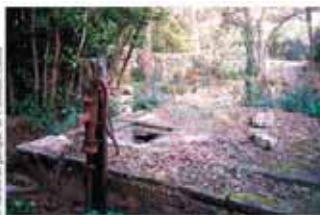
Citerne de récupération des eaux de pluie
