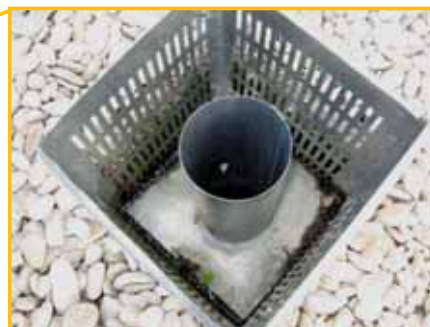
Système d'évacuation régulé (92)
