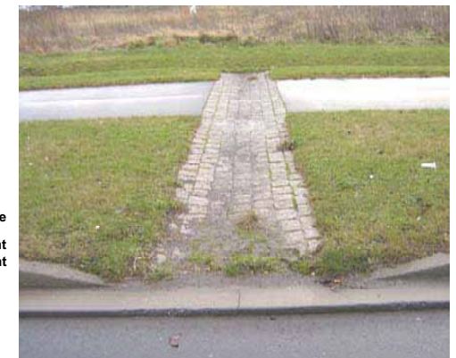
Caniveau de récupération des eaux de ruissellement vers une noue
