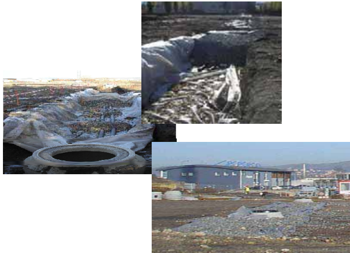
LE CHANTIER: réalisation des tranchées
