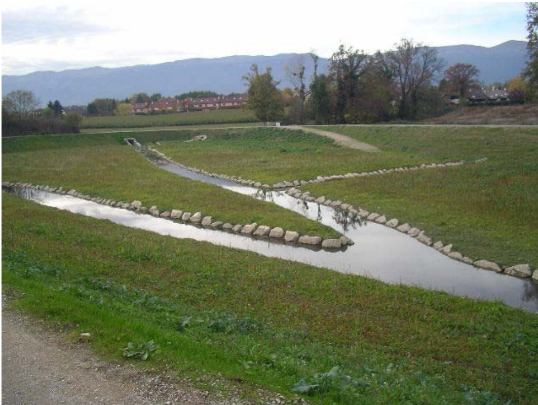
Bassin de rétention à ciel ouvert du Nant
