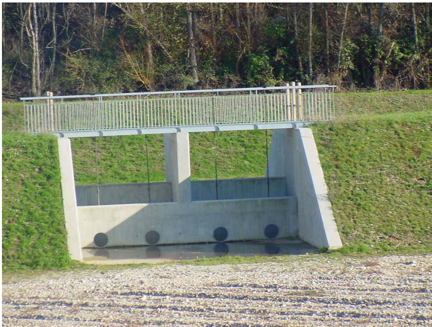
Bassin d'infiltration des Bottes à Beynost : ouvrage d'isolement entre le bassin de décantation et le bassin d'infiltration
