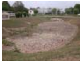
Bassin avec zone colmatée en sub-surface (en eau)
