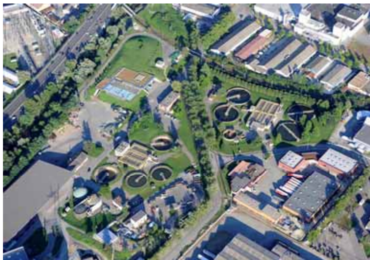
Vue aérienne de l'usine avant les travaux. Tous les bassins à l'air libre seront démolis
