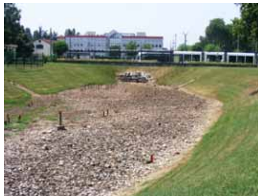
Figure 5 : instrumentation du site de l'IUT.
