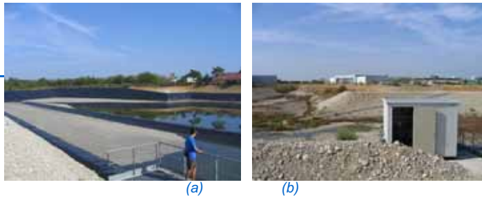
Figure 4 : Site de Chassieu (a) bassin de rétention – (b) bassin d'infiltration
