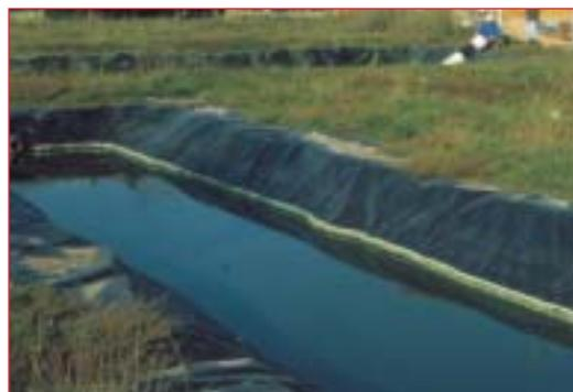
Les fossés lagunants doivent être placés dans une zone ensoleillée, à distance des rideaux d'arbres qui pourraient projeter de l'ombre et produire une accumulation de feuilles. Le terrain doit être plat ou légèrement pentu, un dénivelé d'environ 0,5 m est suffisant. Un terrain trop pentu peut entraîner des frais de terrassement élevés mais une disposition en terrasse peut être envisagée.
