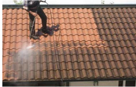
*Figure 2 : Nettoyage haute pression d'une toiture*
