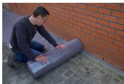
*Figure 37 : Pose de bâches de protection lors d'un traitement de façade*
