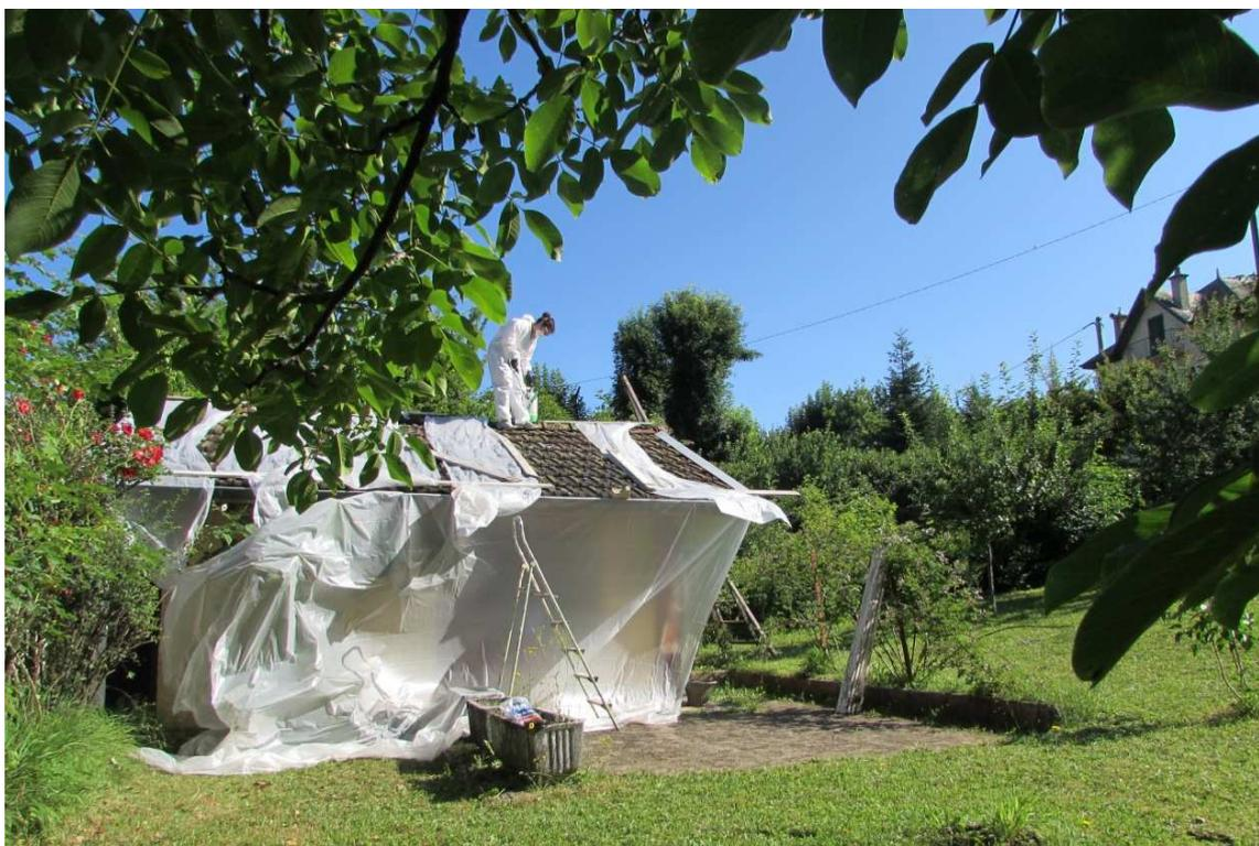
*Figure 29 : Application des anti-mousses sur la toiture.*
