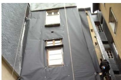
*Figure 36 : Pose de bâche de protection pour un traitement de toiture*
