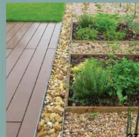
tranchée drainante étroite (25cm) connectée à des carrés potagers
