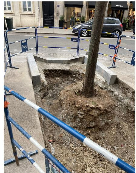
**Figure 3 : les fosses d'eau pluviale agissent comme de mini réservoirs au pied des arbres de pluie**
