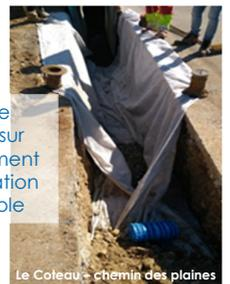
Tranchée infiltrante sur renouvellement de canalisation eau potable
