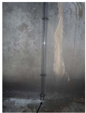
Détecteur de surverse
