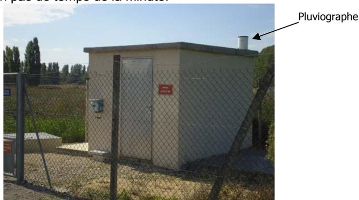
*Illust. 4: Exemple d'installation d'un Pluviographe à augets basculants installé au niveau d'un poste de relèvement
