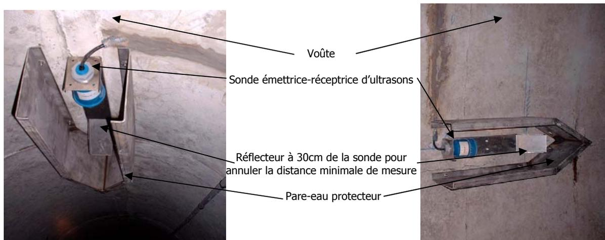
*Illust. 2: Exemple d'installation d'un capteur à US sous la voûte d'un collecteur avec renvoi d'angle
