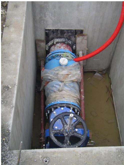
*Illust. 1: Exemple d'installation en réseau (Photo Chambéry métropole)*
