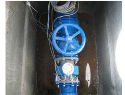
1 débitmètre Ø150 sur conduite de refoulement
