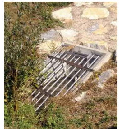
Surverse au pied de l'enrochement
