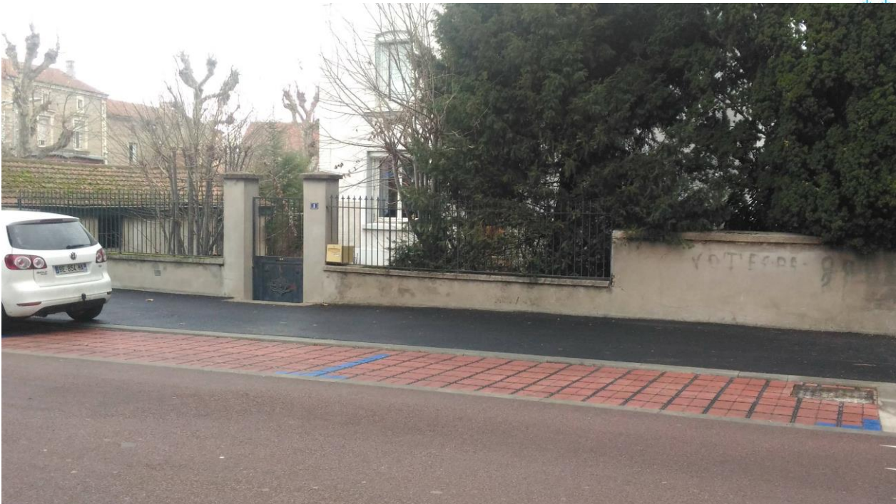
Création de places de stationnement perméables
