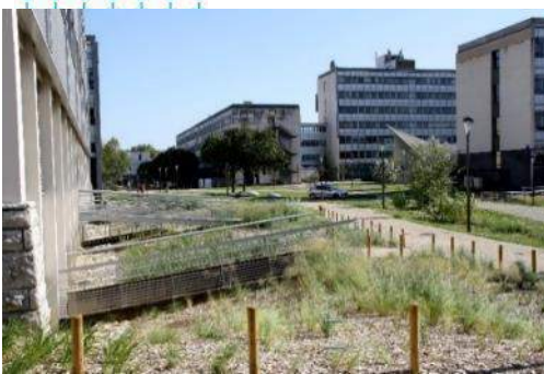
D. Tranchée d'infiltration au pied d'un bâtiment
