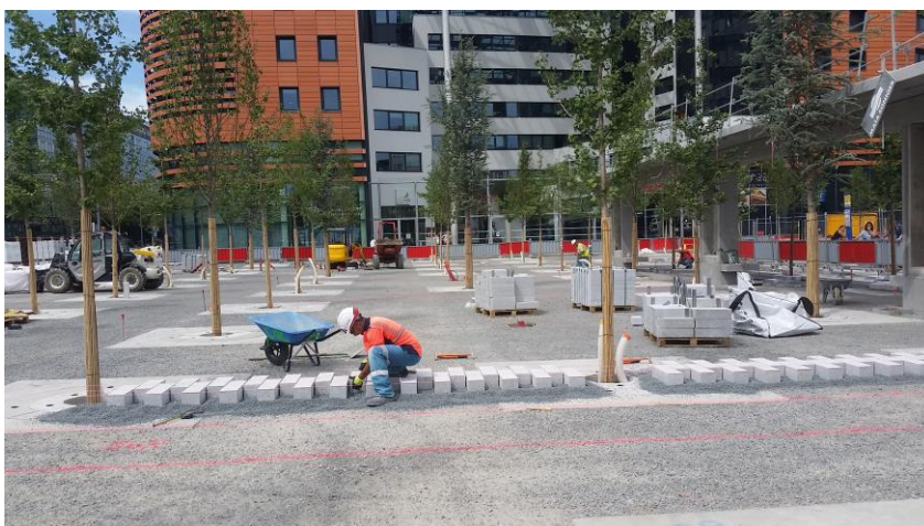
Phase travaux de la place de Francfort : pose des dalles de granit et installation des fosses terre-pierre
