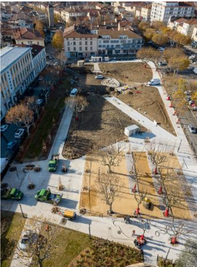
Vue aérienne pendant les travaux d'aménagement
