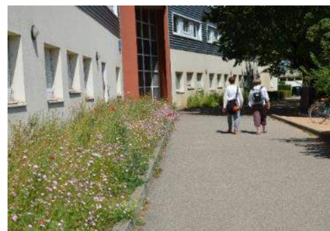
Tranchée d'infiltration plantée au pied d'un bâtiment
