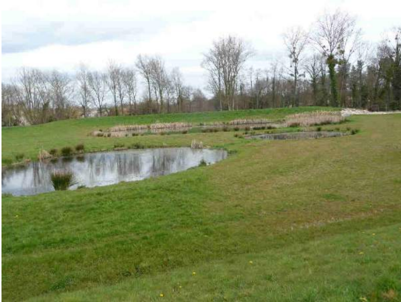
Vue du bassin (A) contenant la mare (D), le bassin de décantation (E) la zone humide (B) et la surverse (C)
