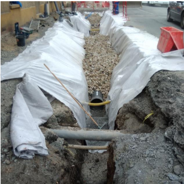
Travaux de mise en place d'une tranchée drainante
