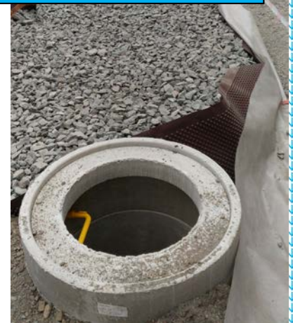
Travaux d'une structure de stockage-infiltration
