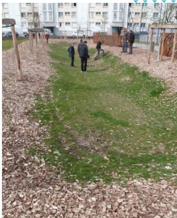
Bassin d'infiltration enterré
