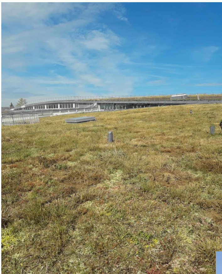
Toiture en faible pente
