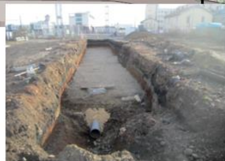
Travaux de la tranchée d'infiltration sous la prairie
