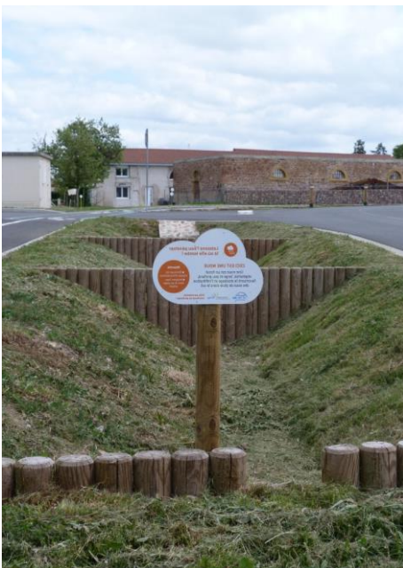
Panneau de sensibilisation du public à la gestion alternative des eaux pluviales
