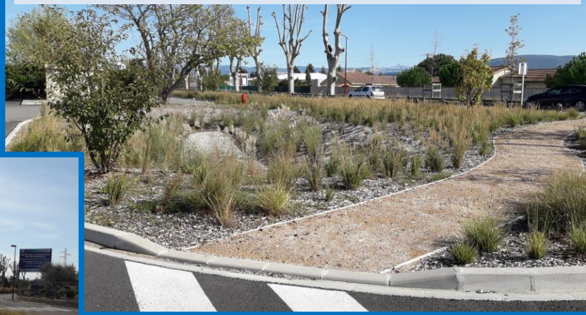
Bassin d'infiltration 2- La Verdière – Graminées et cheminement piétons
