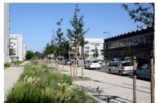
C. Tranchée d'infiltration en bord de voirie
