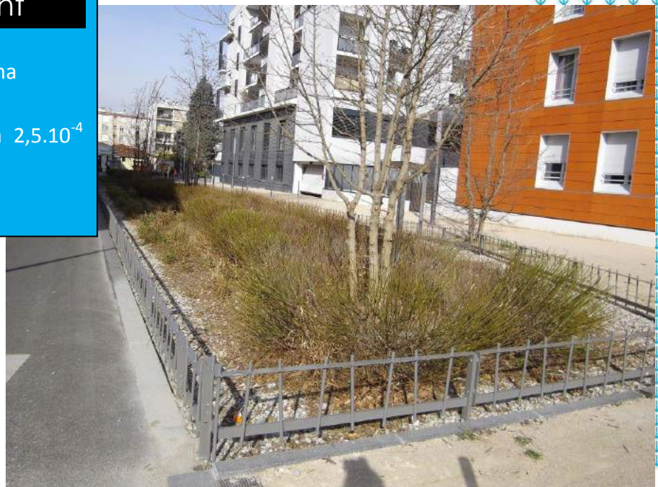
Jardin de pluie pour les eaux de voirie
