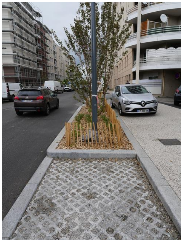
Place de stationnement avec dalles alvéolaires surplombant les tranchées d'infiltration
