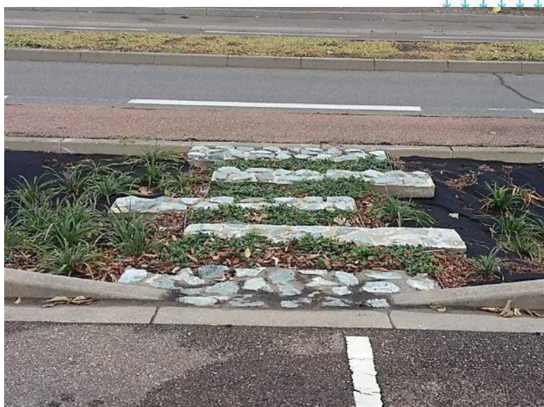
Pas japonais pour cheminement piéton
