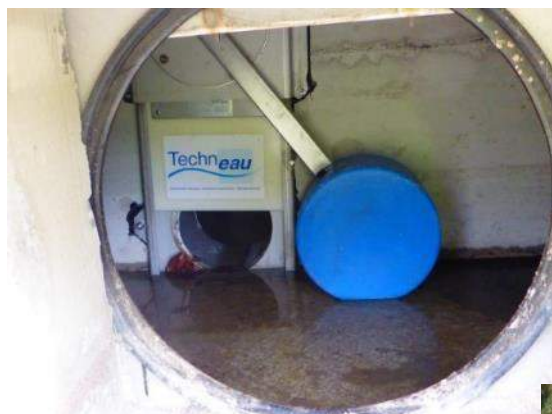
Vue de la vanne sur flotteur
