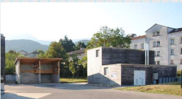
C. La chaufferie bois
