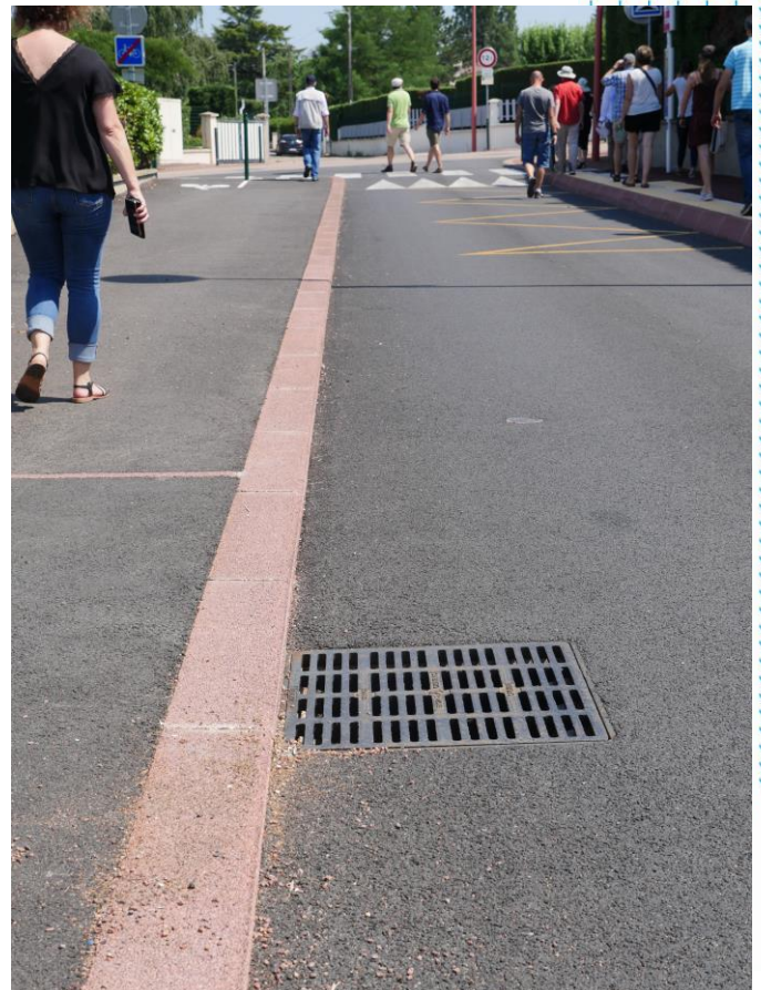
Grille de collecte dans un point bas
