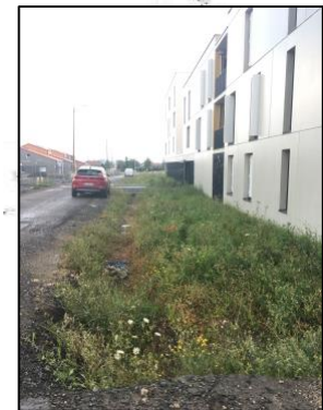
Noues et tranchées drainantes
