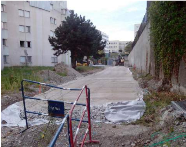
Mise en place de la couche de forme
