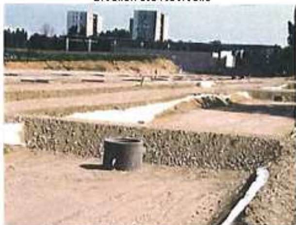
Epandage du ballast avant compactage
