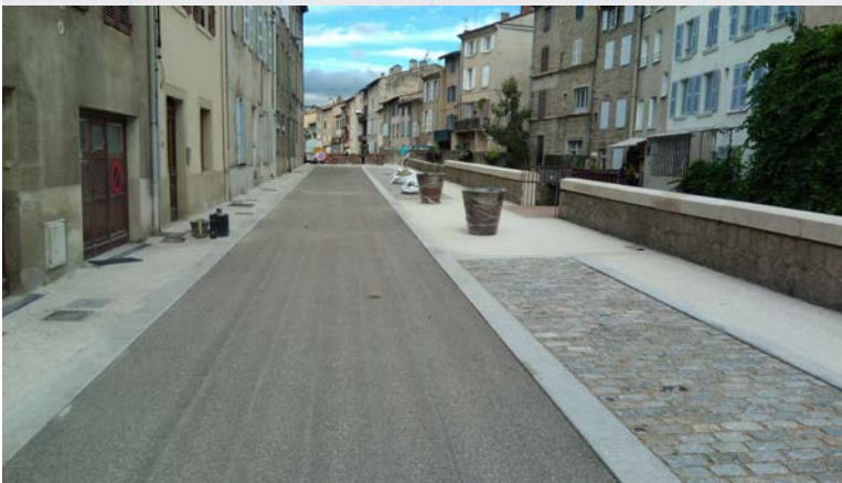
Les quais de l'Astrée après les travaux
