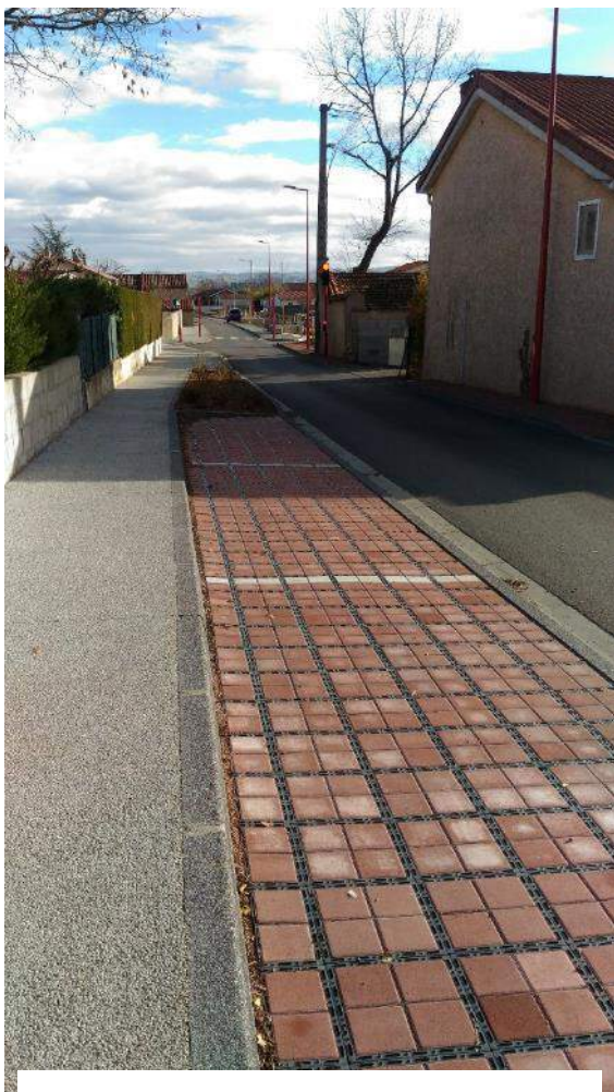
Stationnement en dalles alvéolaires
