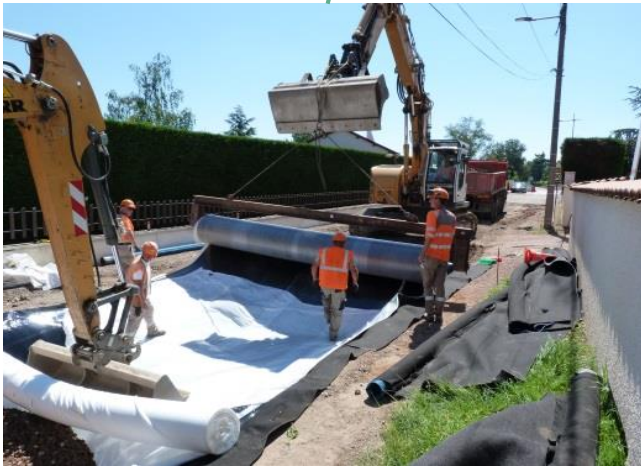
Pose du Géotextile
