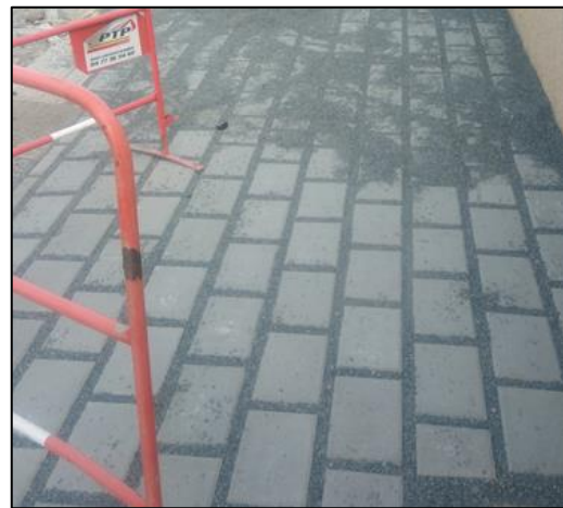
Phase travaux : réalisation de la couche de granulat stockant (à gauche) et pavés drainants (à droite)
