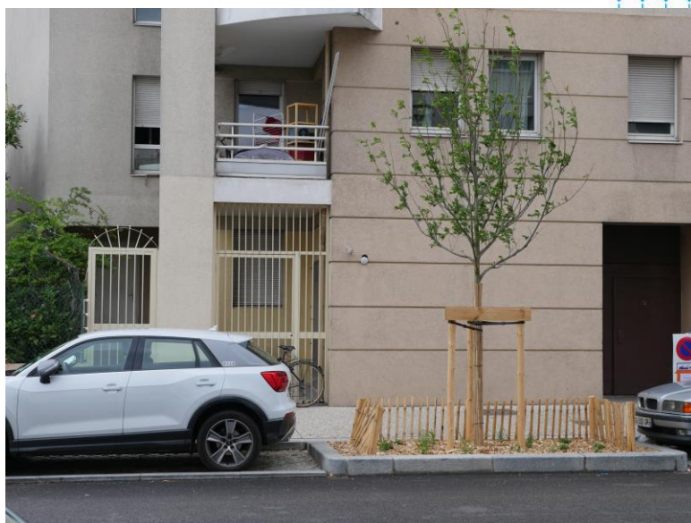
Fosse d'arbre séparant deux places de stationnement
