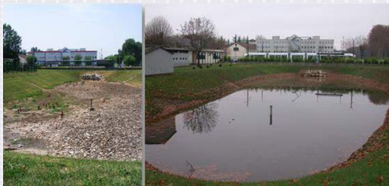
Bassin IUT (photo: GRAIE- OTHU)
