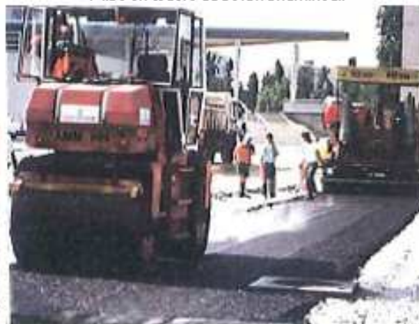
Mise en œuvre du béton bitumineux
