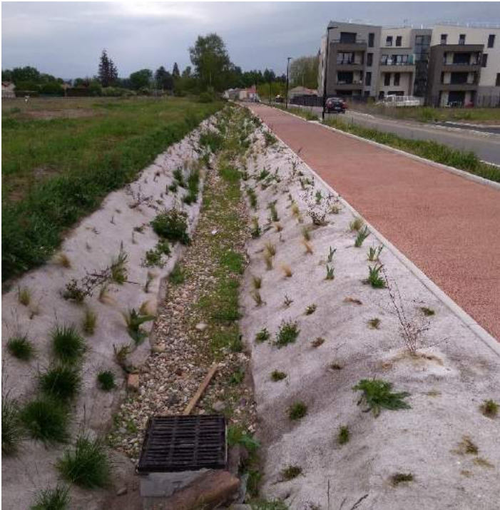
Noe 2 avec surverse en bas et béton drainant à droite
