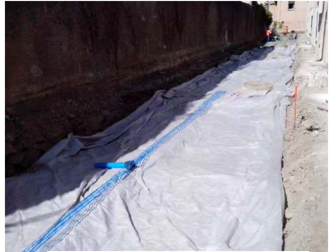
Mise en place de la géomembrane
