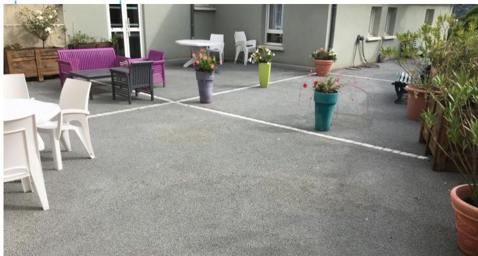
Terrasse revêtue du béton drainant
