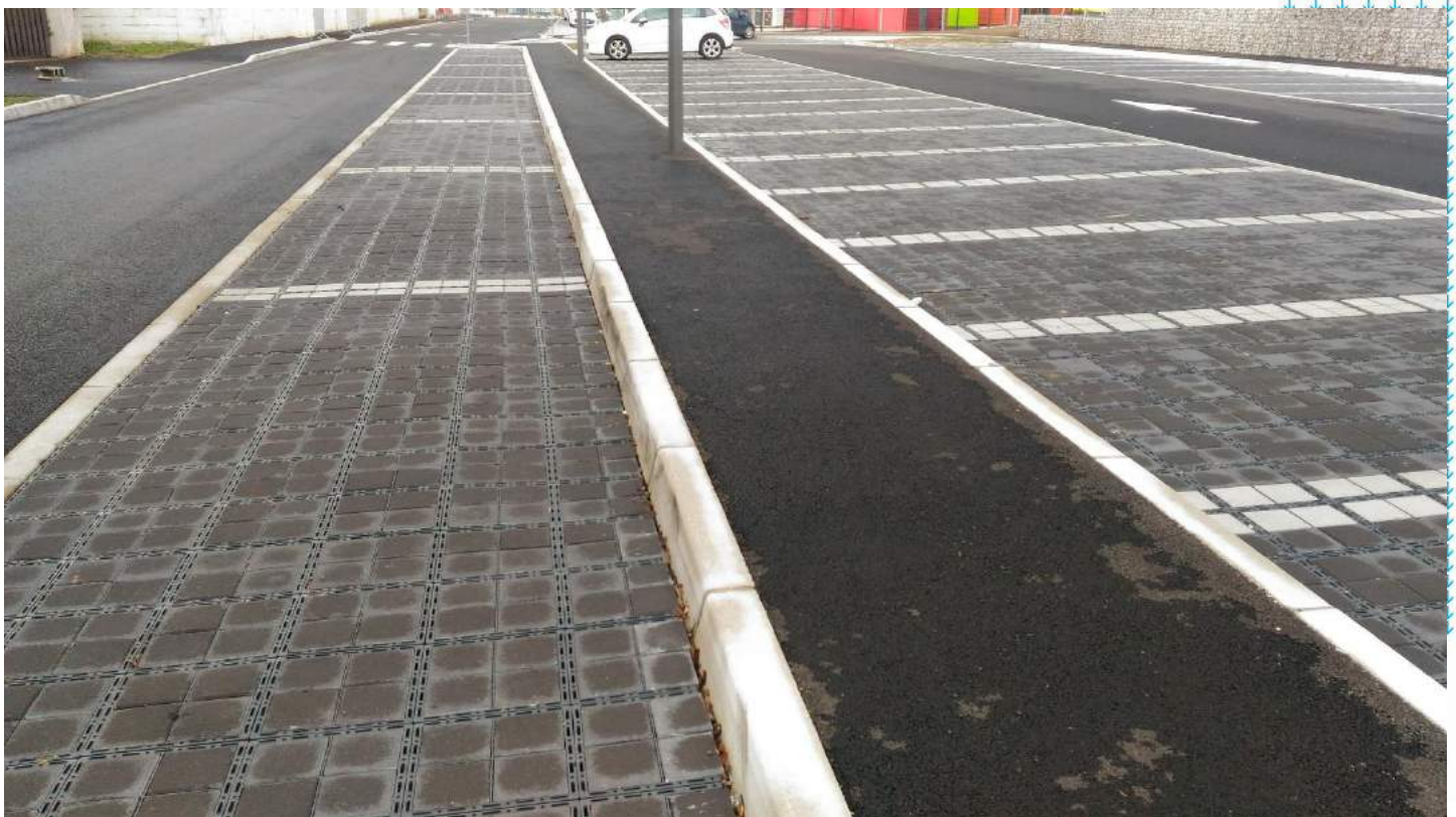
Vue du parking perméable (situé en amont du réservoir)
