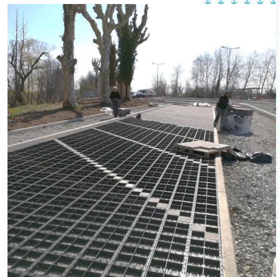
Pose des structures poreuses sur le stationnement
