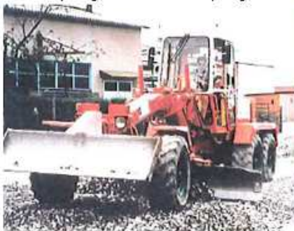
Epandage du ballast avant compactage
