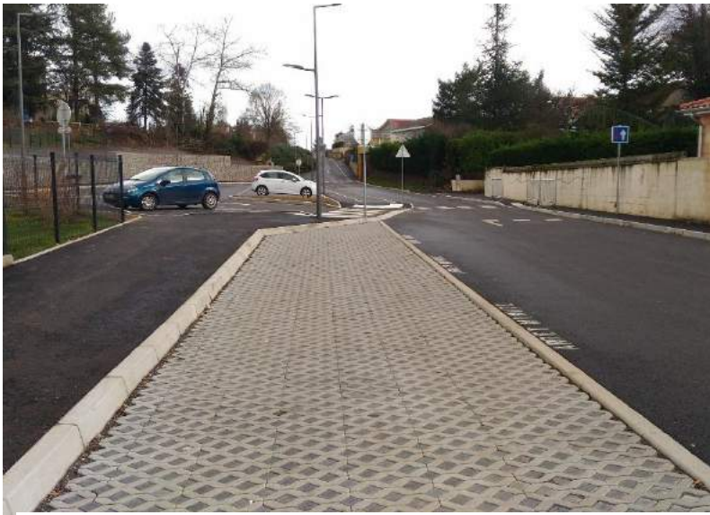
Vue du parking perméable (situé au droit du réservoir)
