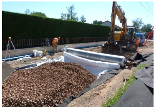
Pose des couches de grave
