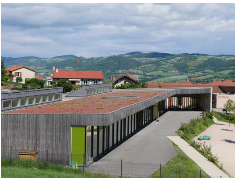
Toiture végétalisée de l'école
