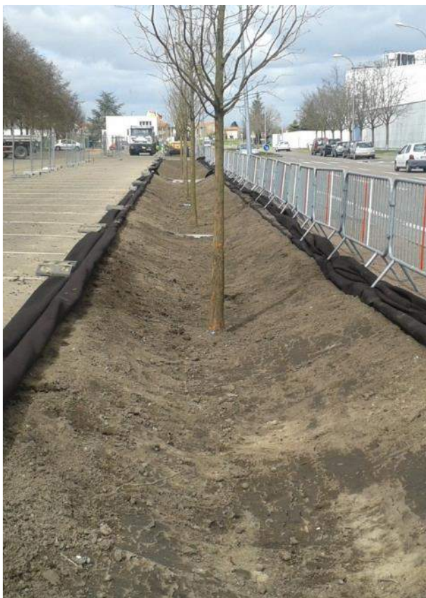
Noue en phase chantier
