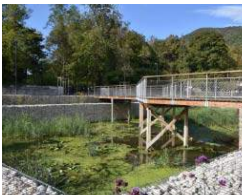
Bassin en eau (pluie annuelle)
