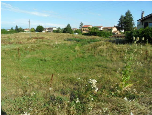
Bassin de rétention/restitution
