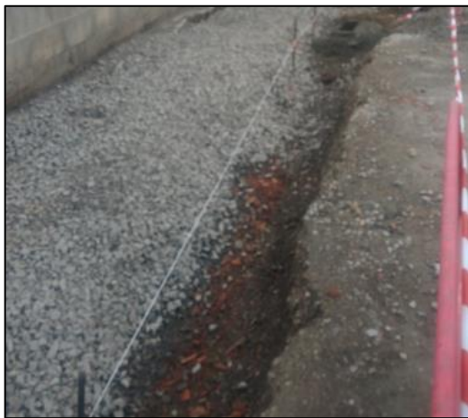
Phase travaux : réalisation de la couche de granulat stockant (à gauche) et pavés drainants (à droite)
