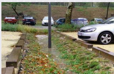
A/ tranchée expérimentale
