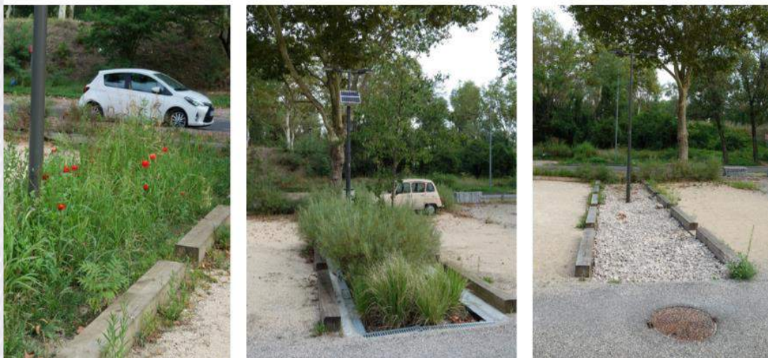
A gauche la noue imperméabilisée, au centre la noue « apport » et à droite la tranchée
