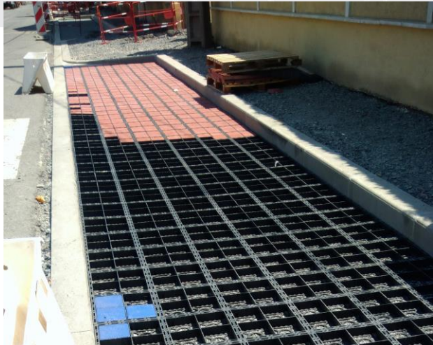
Pose des dalles alvéolaires et des pavés sur les places de stationnement
