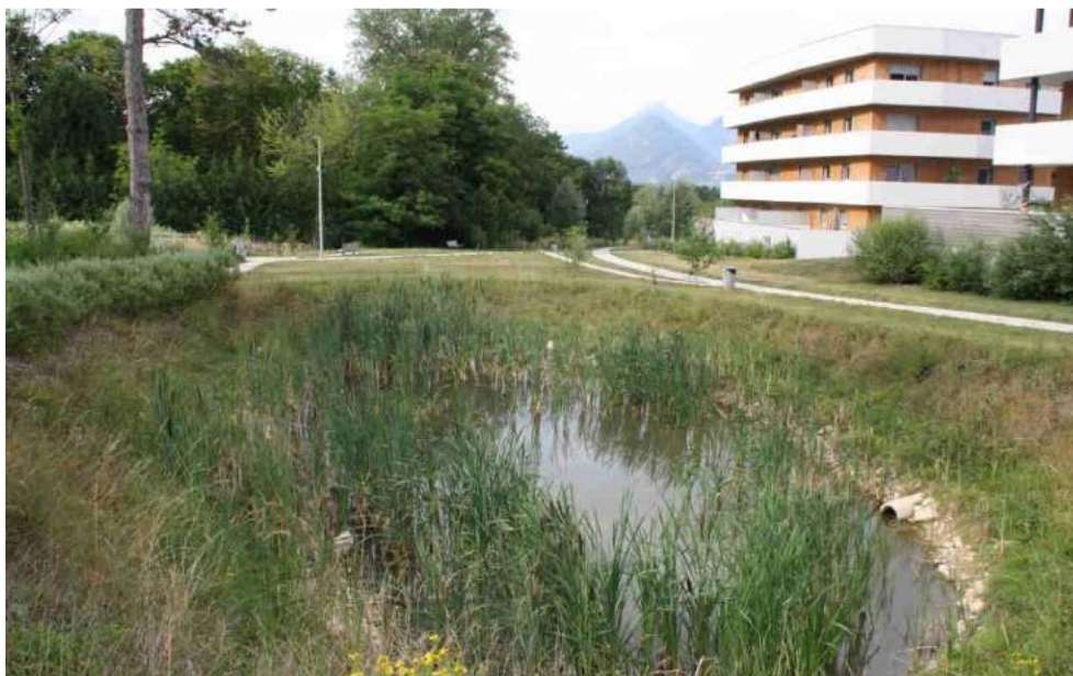
Bassin en eau
