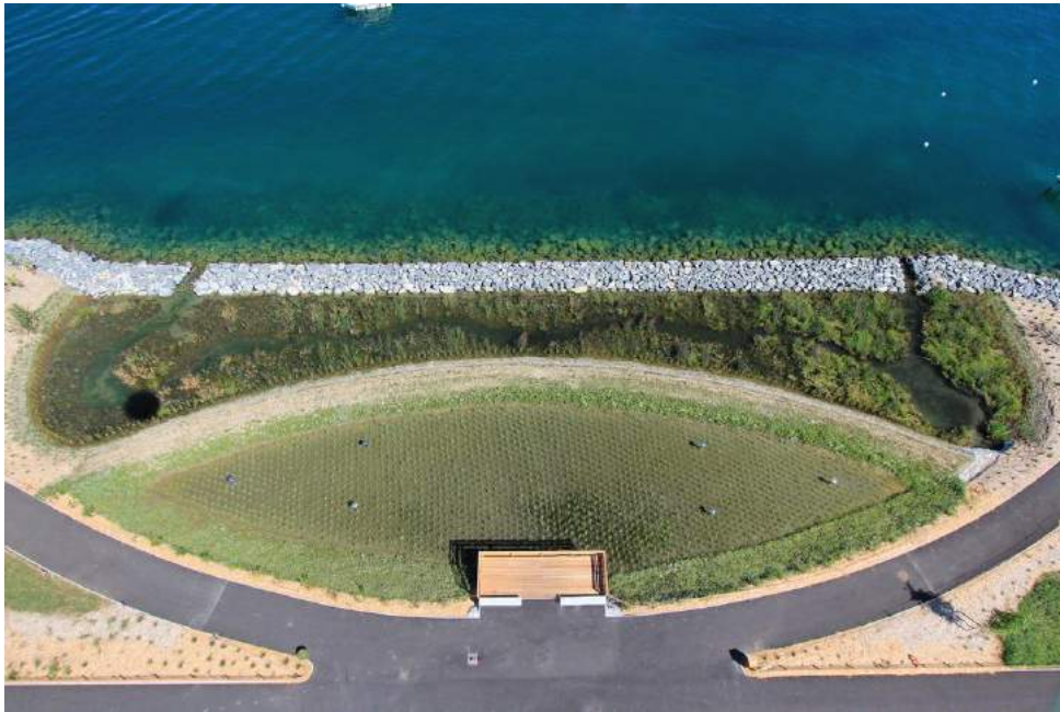
Filtre Planté de roseaux et zone humide à l'achèvement des travaux
