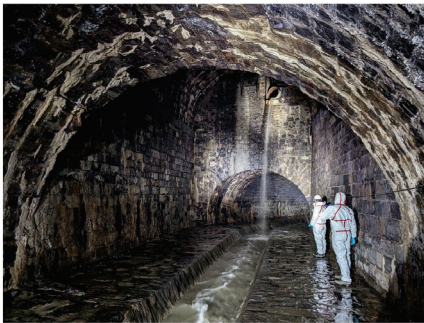
Photo de Frédéric Cherqui, INSA, prise en mars 2024 à Lausanne, Suisse. « La galerie du Flon, héritage du 19 e siècle, invisible de toutes, est pourtant une des clés de voûte du système d'évacuation des eaux usées et pluviales des lausannois. »
