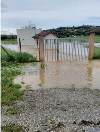
Photo de Sylvain Devidal, Vienne Condrieu Agglomération. « Inondation poste de relevage »
